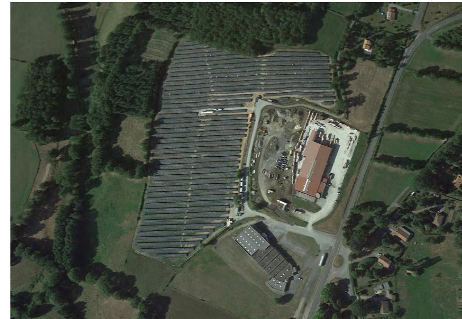
Paysage photovoltaïque en Haute-Vienne – vue aérienne
