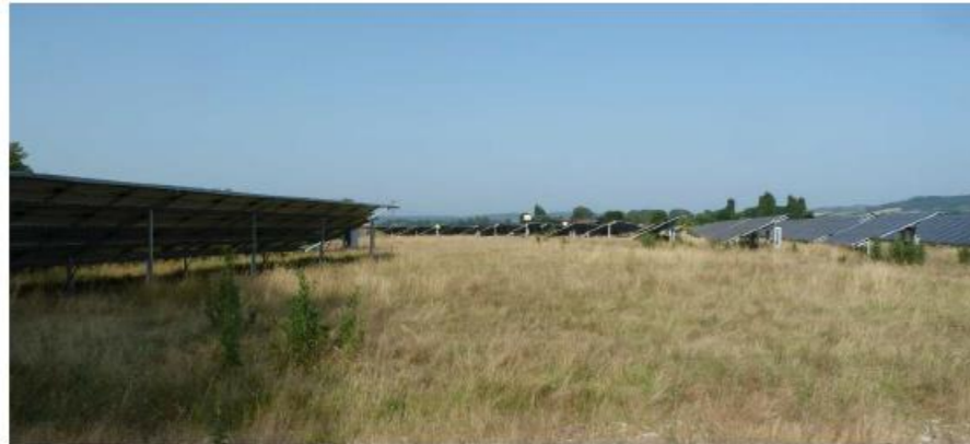
Exemples d'enherbement sous structures photovoltaïques (crédit photo Ectare)
